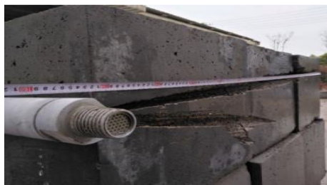
图11 地面切割试验
